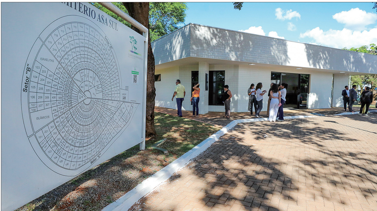
Novo prédio localizado no cemitério Campo da Esperança, na Asa Sul, tem capacidade para 12 cremações por dia
