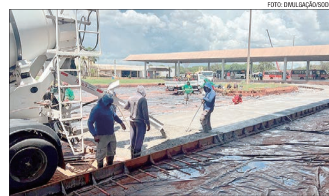
Piso da estação não suportava mais o tráfego intenso de ônibus
