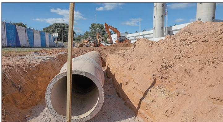
Rede de escoamento tem aproximadamente 200 metros de extensão
