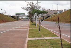
Pavimento foi todo reformado e placas de concreto substituídas
