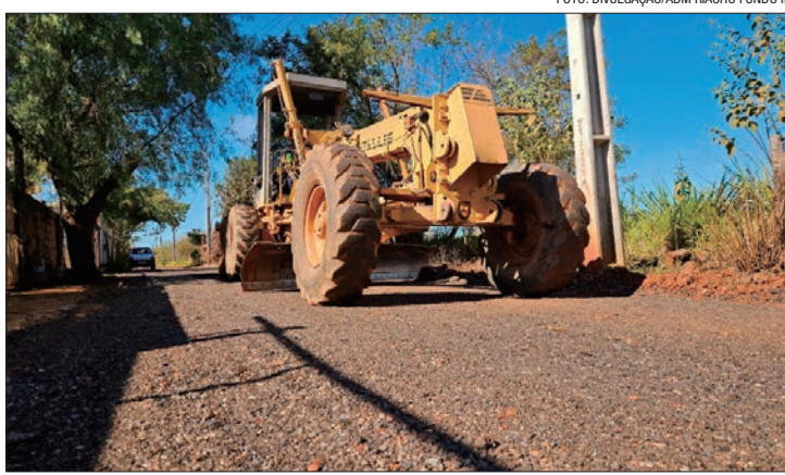
As obras beneficiam os moradores, estudantes e produtores da região
