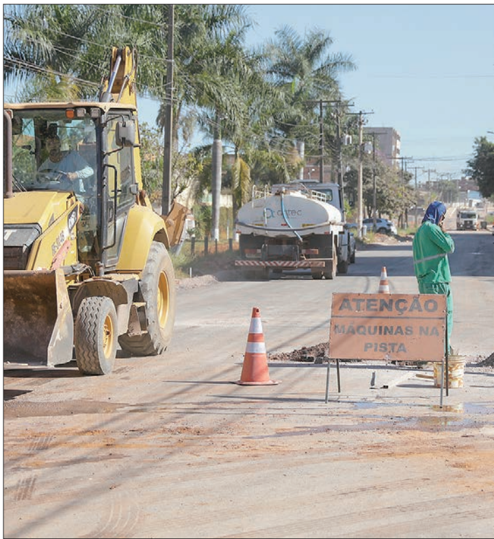
Drenagem e calçadas acessíveis complementam as obras no setor
