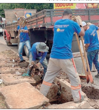
Mutirão de limpeza em Ceilândia desobstruiu 20 bocas de lobo
