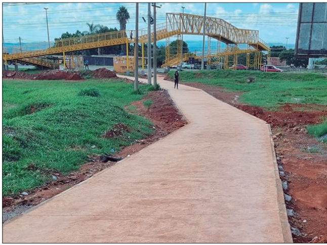
Ceilândia tem 80 km de calçadas construídas ou recuperadas
