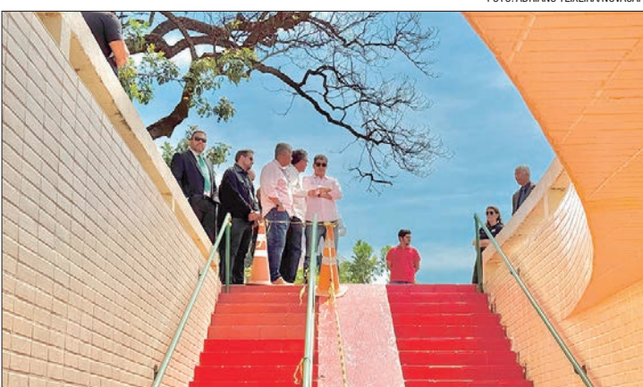
Na SQS 102 obra foi concluída e ganhou vigilância de videomonitoramento
