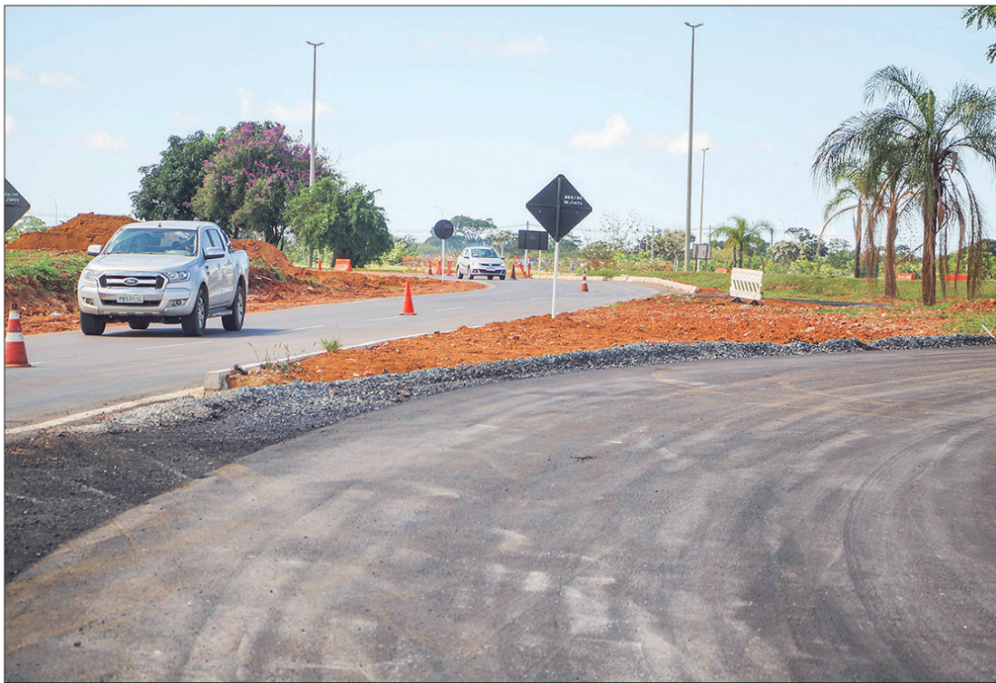
Trabalho englobou dois tipos de intervenções: pavimentação asfáltica em vias e estacionamento e fresagem
