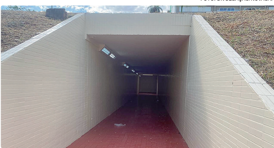
Ppassagem recebeu pintura com tinta que oferece maior durabilidade e facilita limpeza
