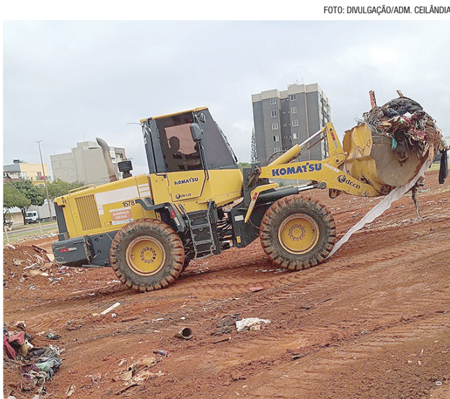
Mobilização eliminou acúmulo de resíduos para evitar alagamento
