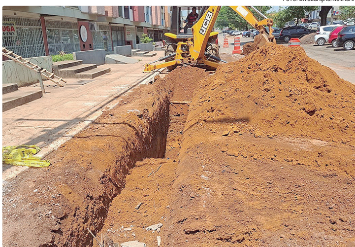
Foram feitas desobstrução de rede, tubulações e novas bocas de lobo
