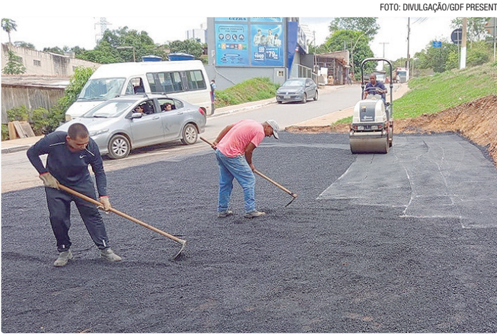
Pavimentação utiliza resíduos da construção civil, os chamados RCC
