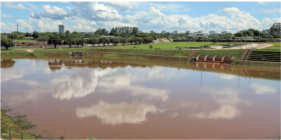
Bacia de retenção retém resíduos sólidos, evitando que o lixo siga para o Lago Paranoá, como ocorreu por anos
