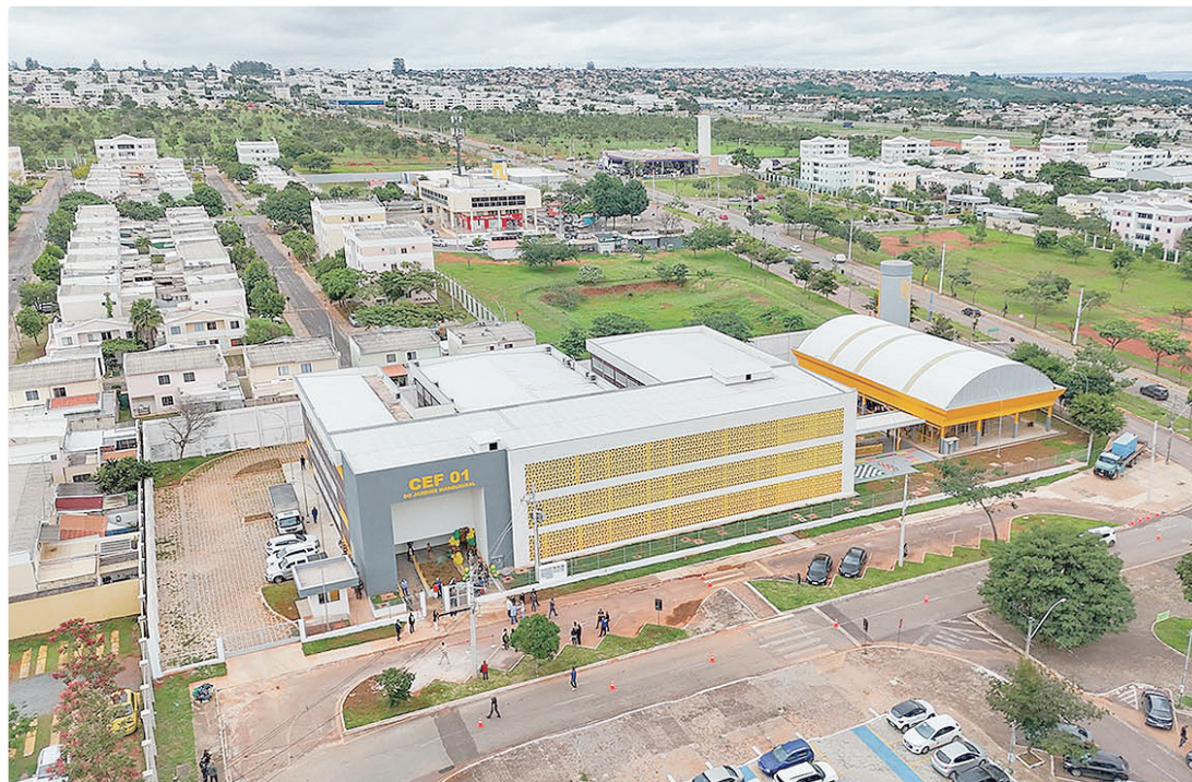
Com 20 salas de aula distribuídas em três pavimentos, o CEF 1 resolve a estrutura educacional na região
