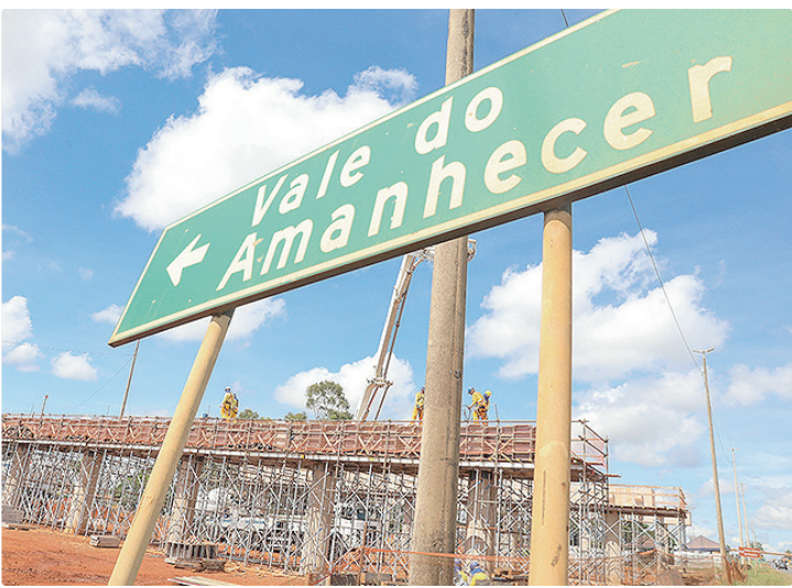
Cerca de 90 mil motoristas passam pelo viaduto de Planaltina diariamente
