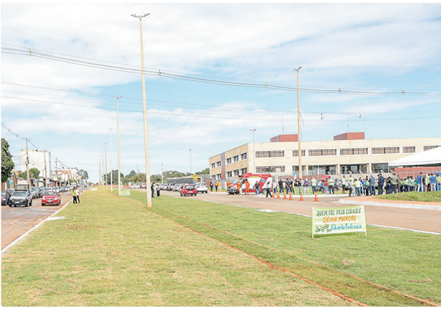
Núcleo Rural Sobradinho e Itapoã passam por obras de pavimentação
