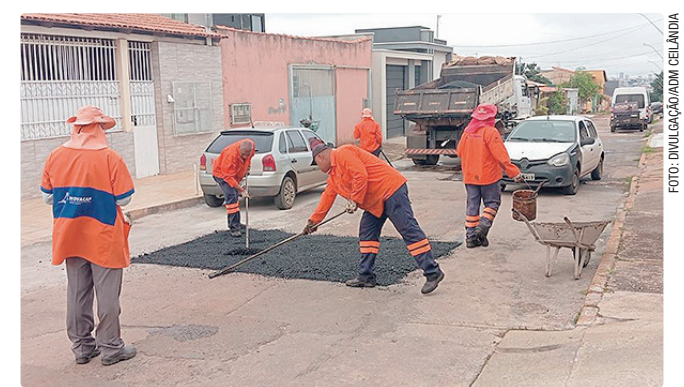
Na pavimentação, foram aplicadas mais de 7 toneladas de asfalto
