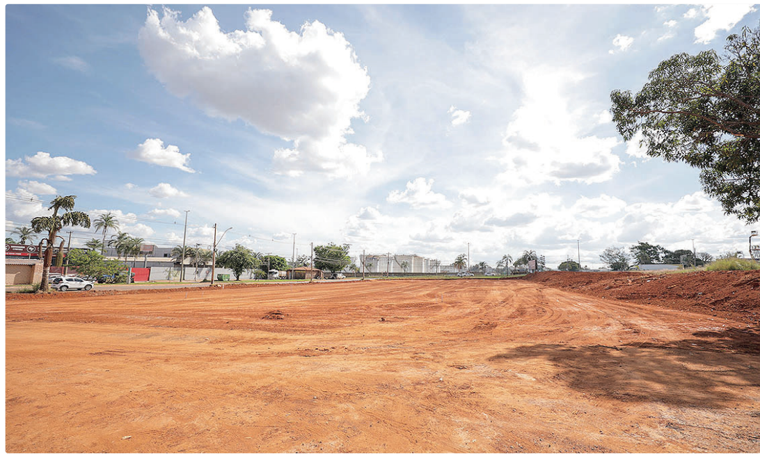
Obra está em andamento desde o início de abril e já passou por limpeza, nivelamento e retirada de vegetação
