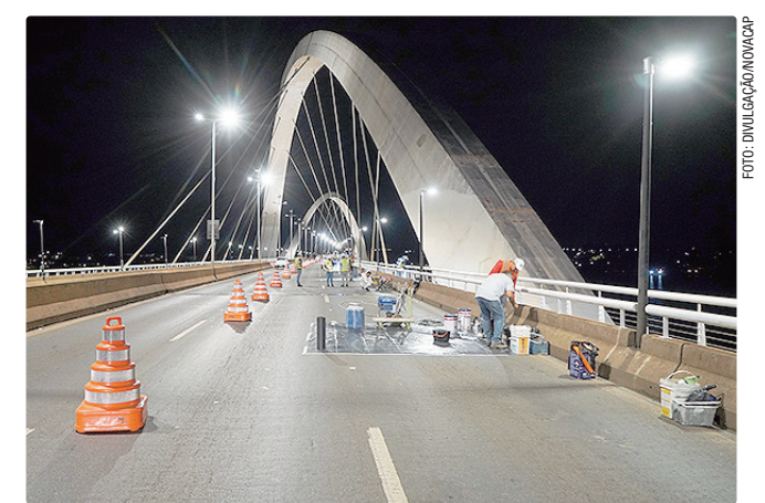
Recuperação visual e estrutural está voltada às colunas e curvas
