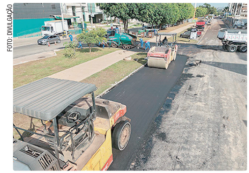
Obra entra na fase final de execução; mais de 5,5 km de vias renovadas com cerca de 6,5 mil toneladas de massa asfáltica
