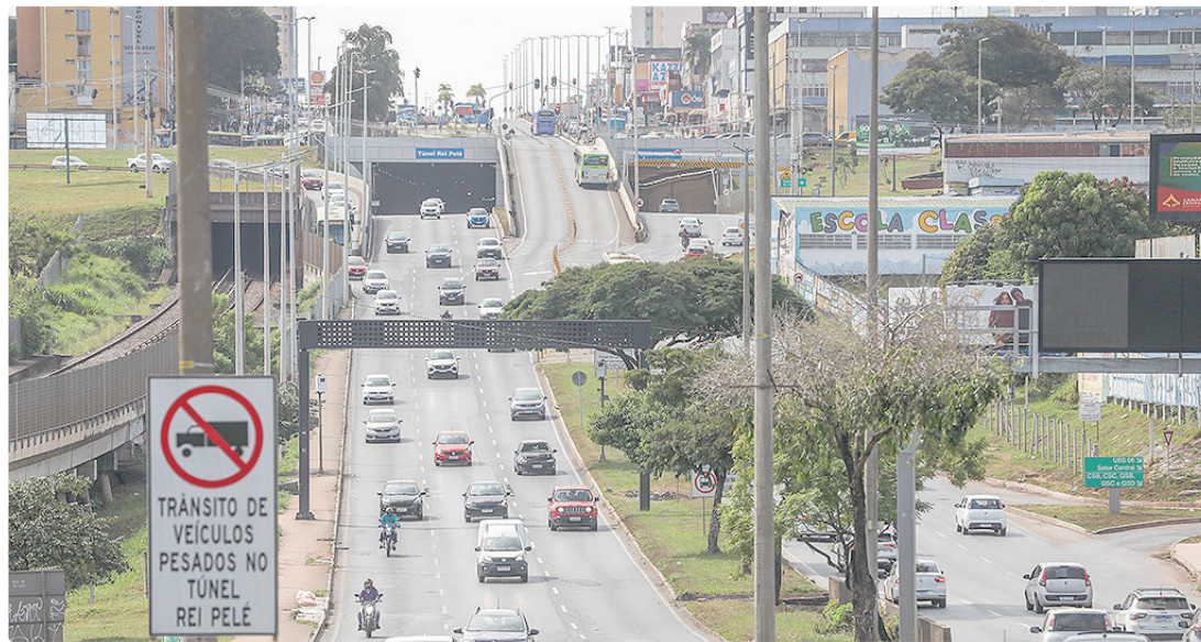
O Túnel Rei Pelé abriu mais espaço para pedestres na parte superior e mudou a paisagem do centro de Taguatinga
