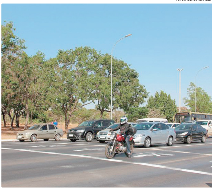
Interdição é para continuar obras de remanejamento de adutora de água
