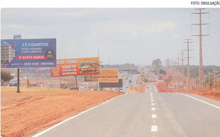
Reversão será feita do entrocamento da EPCT até o início da DF-495
