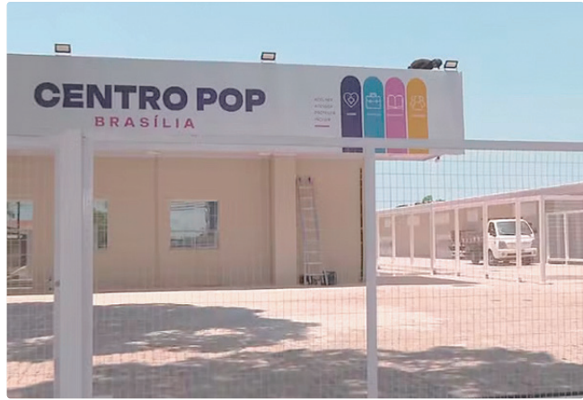
O novo espaço fica no Setor de Garagens e Oficinas Norte
